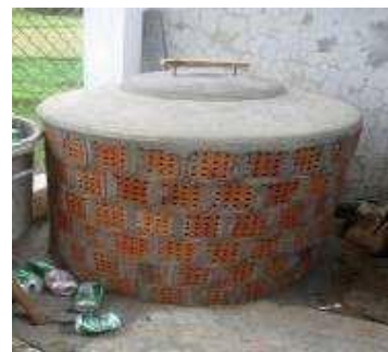
Hình 135: Bể bioga hộ gia đình
